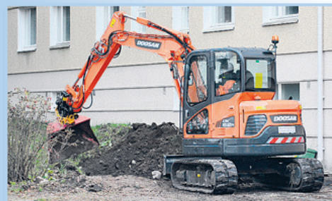
Doosan DX62R Tesoman viherkannustustyömaalla engconin rototilillä ja vihertöihin soveltuvalla luiskakauhalla varustettuna.
