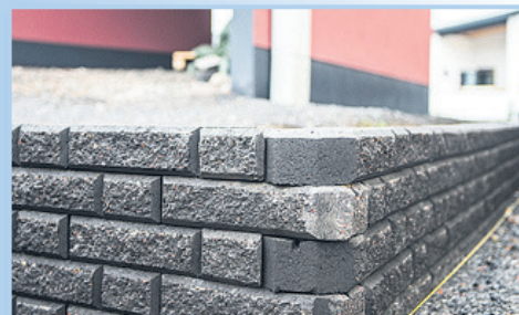
Pihatyöt tehdään tarvittaessa täysin valmiiksi myös kiveysten osalta. Kuvassa huolellisesti perustettu tukimuuri.
