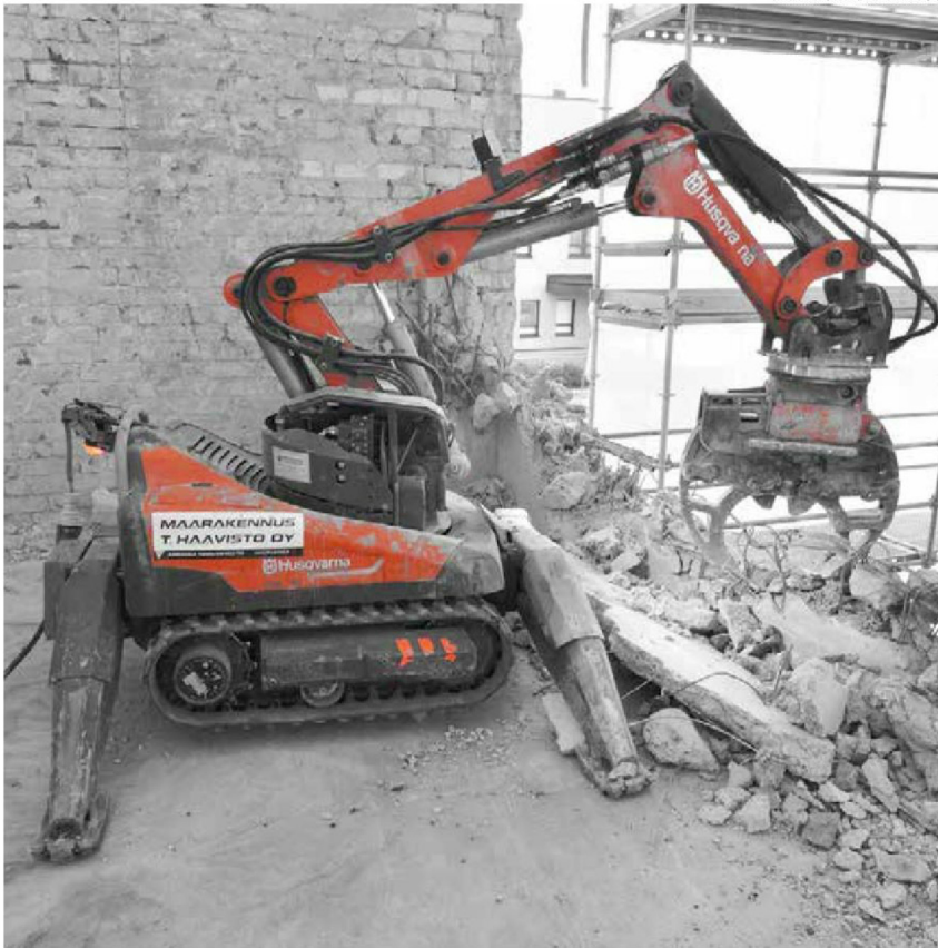
Perinteisten kaivureiden rinnalla maanrakennusyrityksessä tarvitaan myös kevyempää kalustoa. Tässä on piikkausrobotti työssään Hatanpään sairaalassa.
