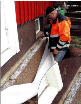
ISODRÄN® -levytyksen ansiosta kaivumassat voidaan käyttää uudelleen täytöksinä.
