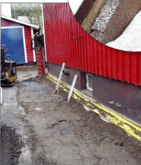
Kellarin veden- ja lämmöneristys sekä routaeristys ovat rintamamiestalon remontin jälkeen kunnossa. Talon isännän mukaan seuraavaksi on tarkoitus uusia kellarin vanhat pikkuikkunat, jotta lämpö karkaa niiden kautta.
