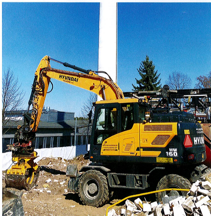
Maarakennus T. Haavisto hoitaa myös purku- ja saneerauspurkutöitä kaiken kokoisille asiakkaille. Kuvassa ollaan Pirkkalassa voimalaitoksen purkutyömaalla.
